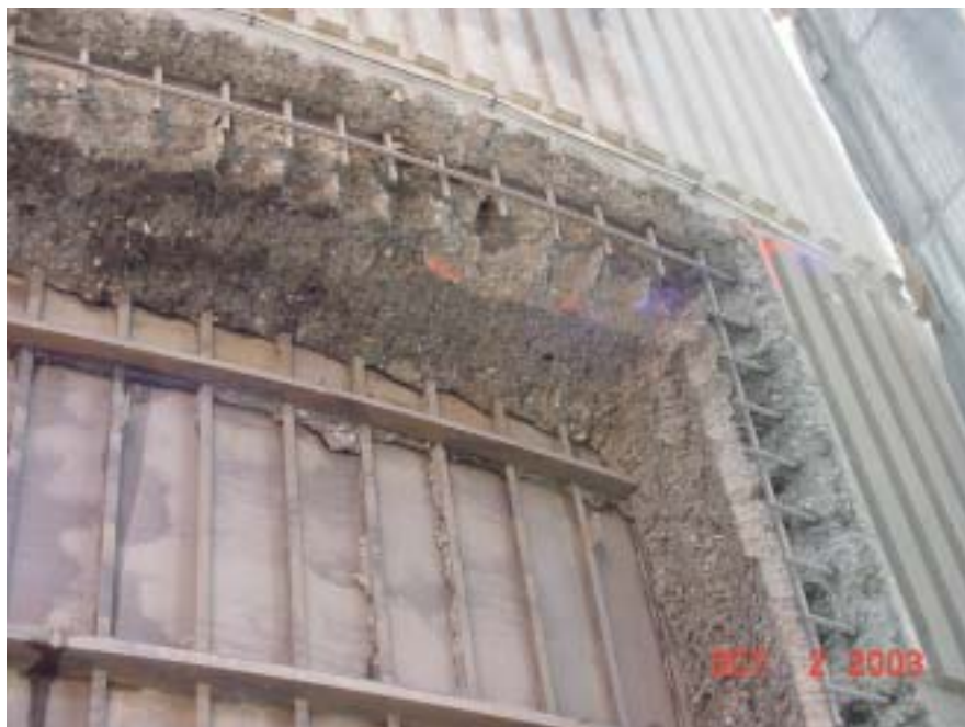
Fig. 3 - Découpe de l'enceinte extérieure en béton d'un réacteur
